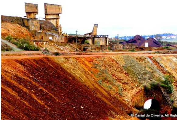
Vista da zona de fábrica da Achada do Gamo
